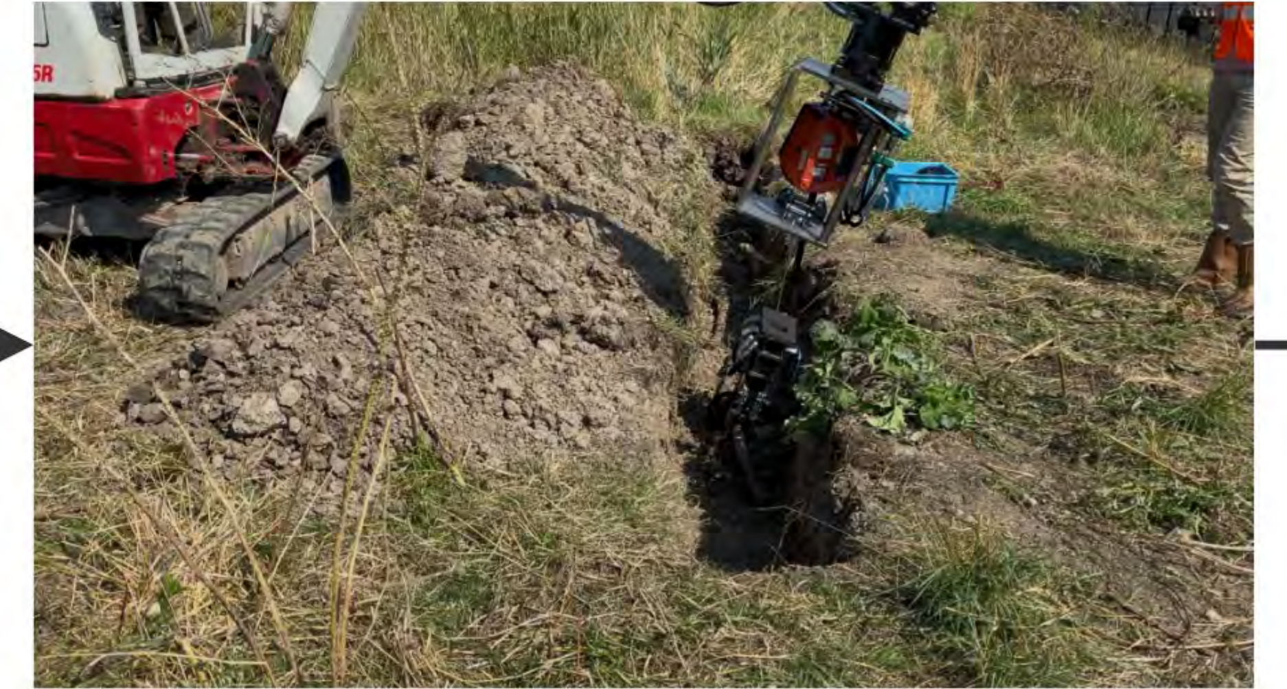
Graafmachine laten zakken terwijl het onderste stuk van de end-effector omhoog wordt getrokken (met de lier).
