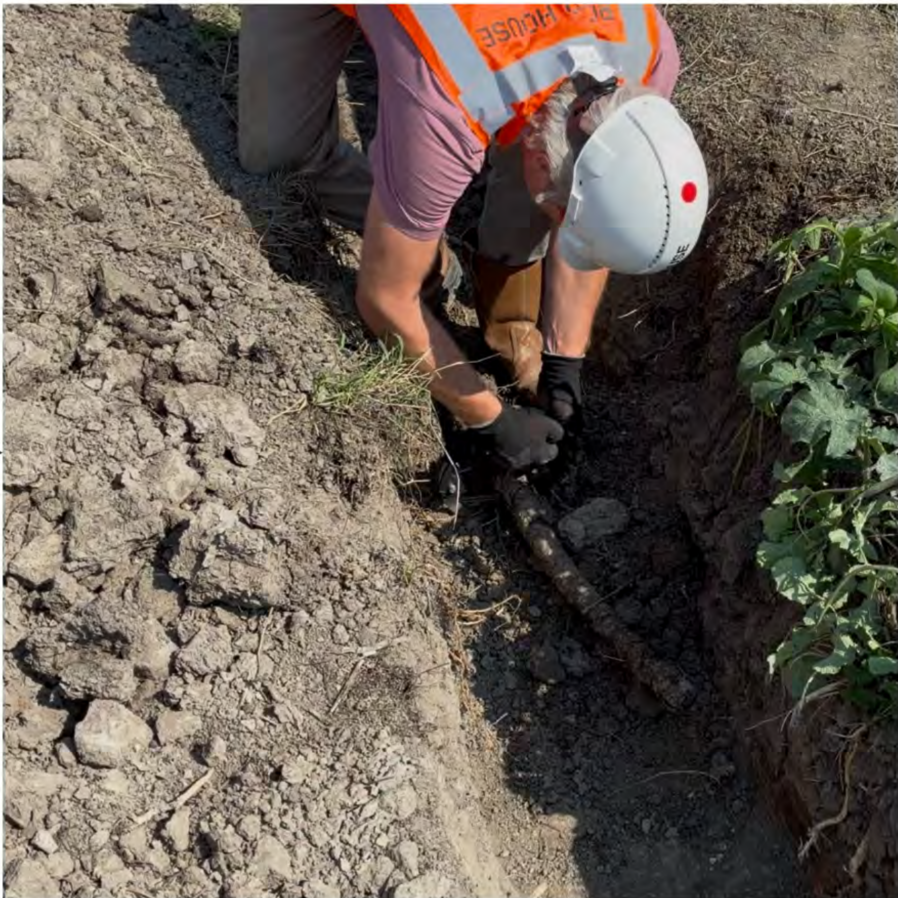
Vast zetten met een tyrap
