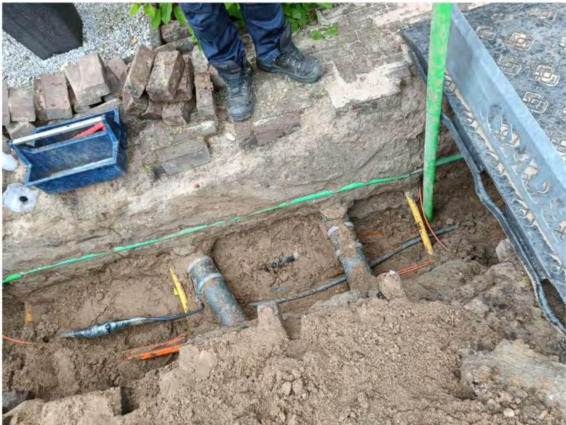
De overweging om ergens de knip te zetten hangt samen met onder welke andere infrastructuur het weg getrokken wordt. Andere infrastructuur moet in zicht zijn om er zeker van te zijn dat het niet meegetrokken wordt als het er onderdoor moet.
