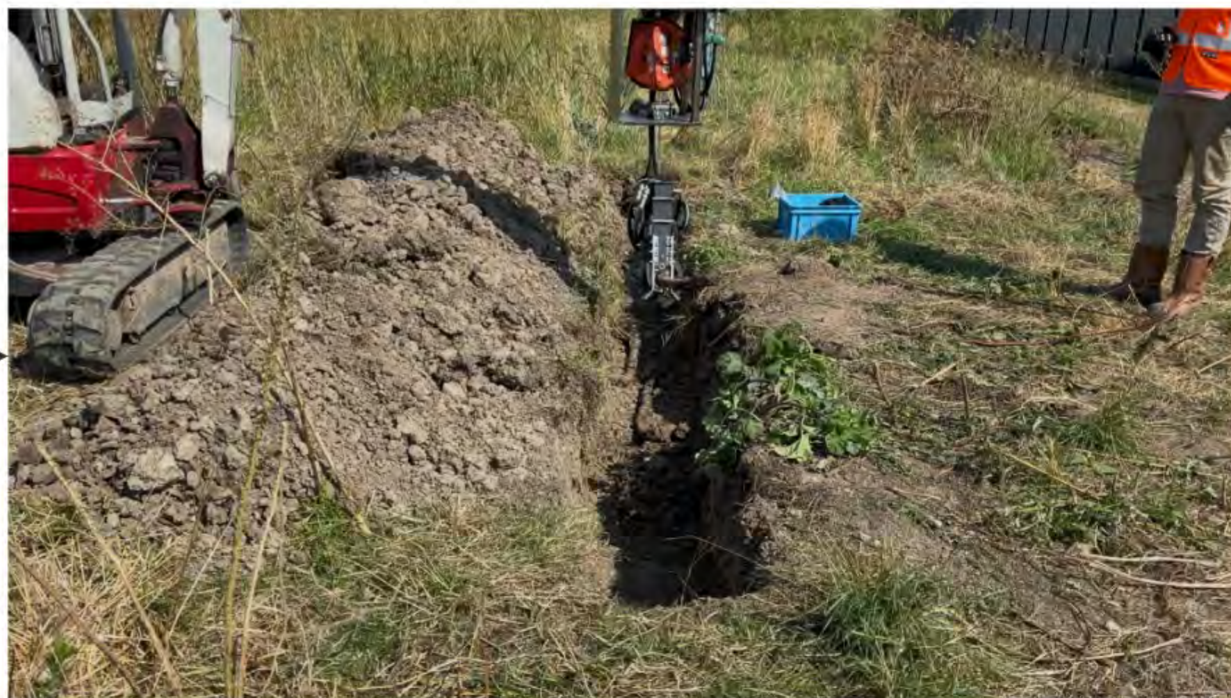
End-effector met module en kabel schuin uit de geul trekken.
