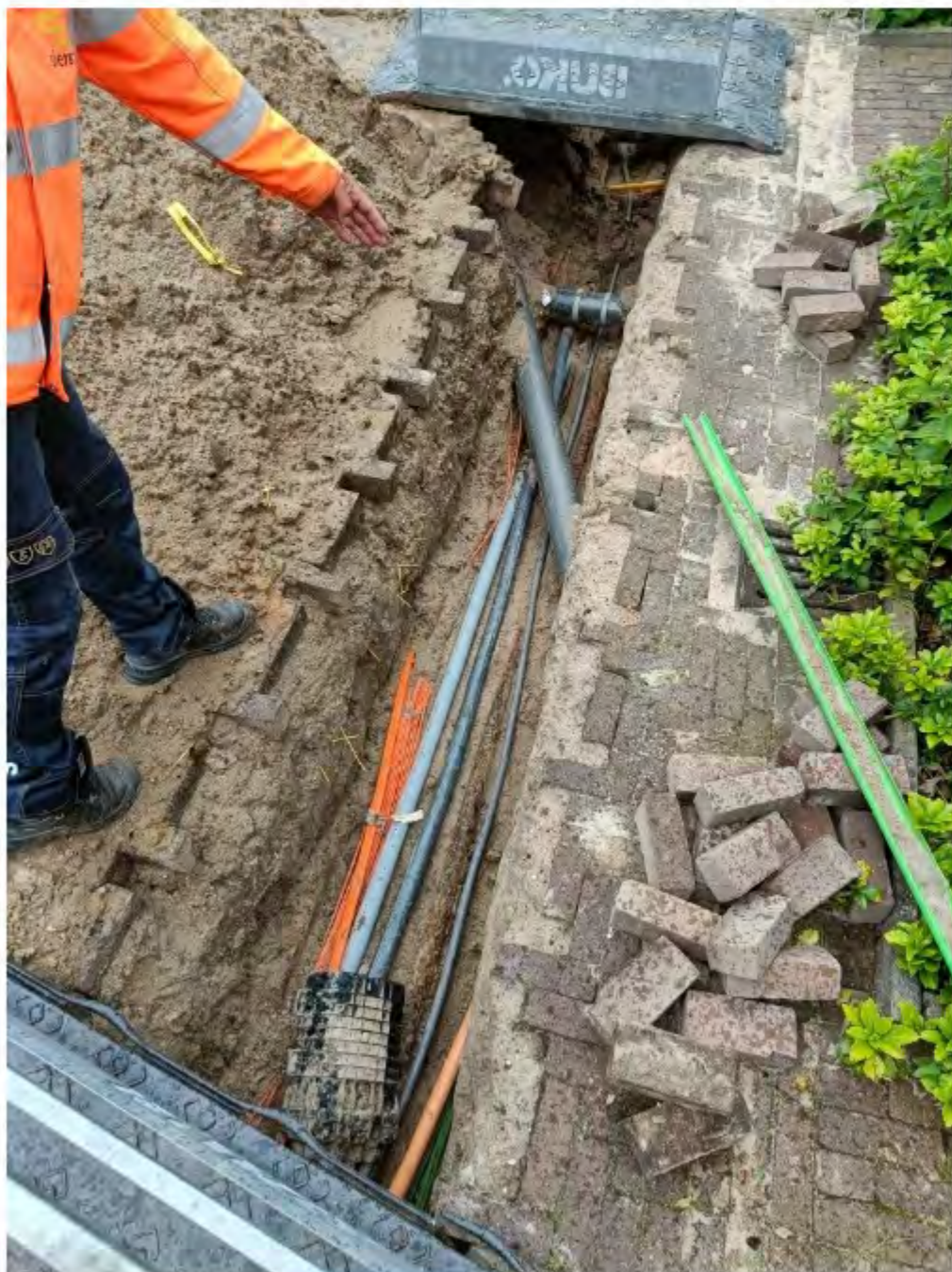
Er is niet veel ruimte rond de oude kabel. Niet alles is in eerste instantie zichtbaar. Ervaring van "de geul" wordt gebruikt om te voorspellen wat er verwacht kan worden. Zoals moffen of gasleidingen.
