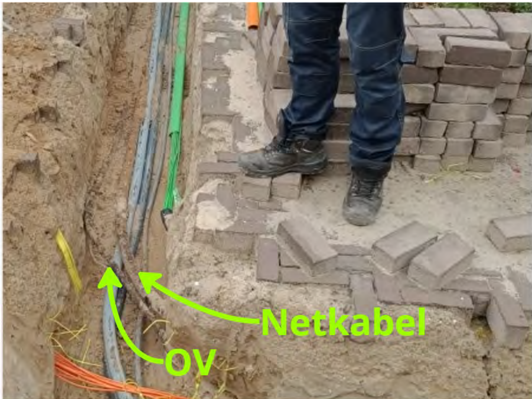
In dit geval loopt er een OV kabel parallel mee met de netkabel. Deze moet ook geknipt en verwijderd worden.
