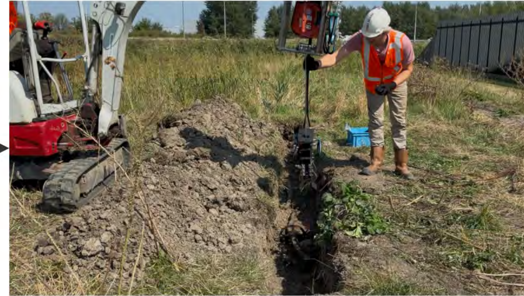
End-effector laten zakken, onder begeleiding van grondwerker
