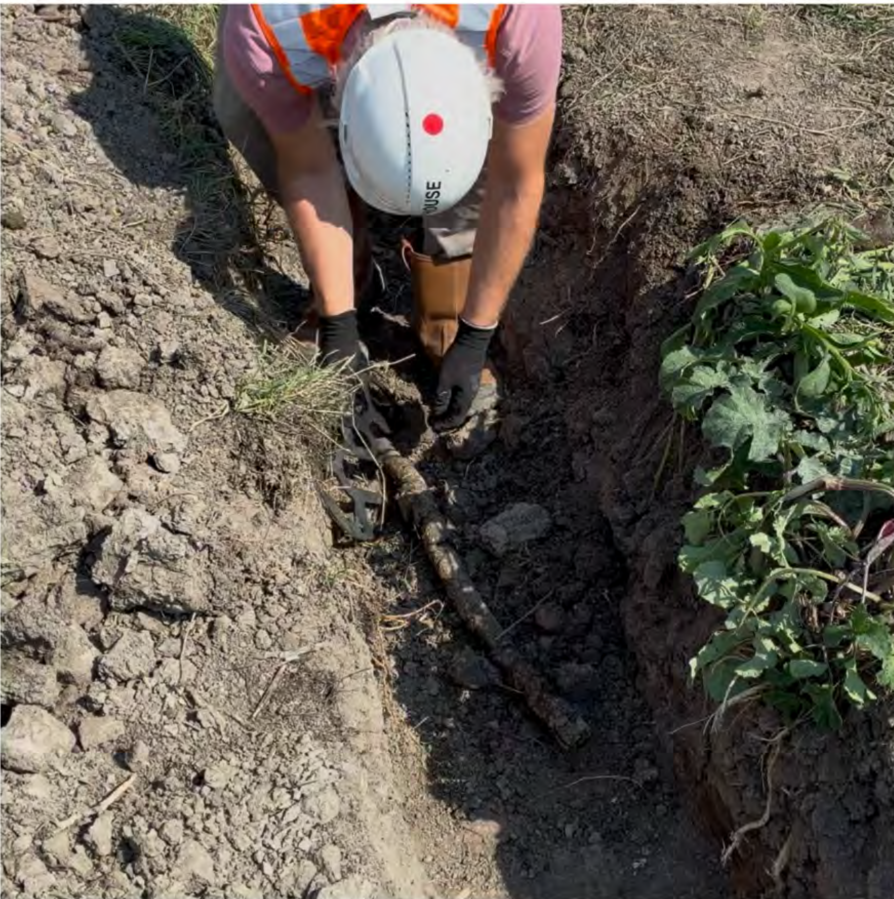
Module onder kabel door schuiven.
