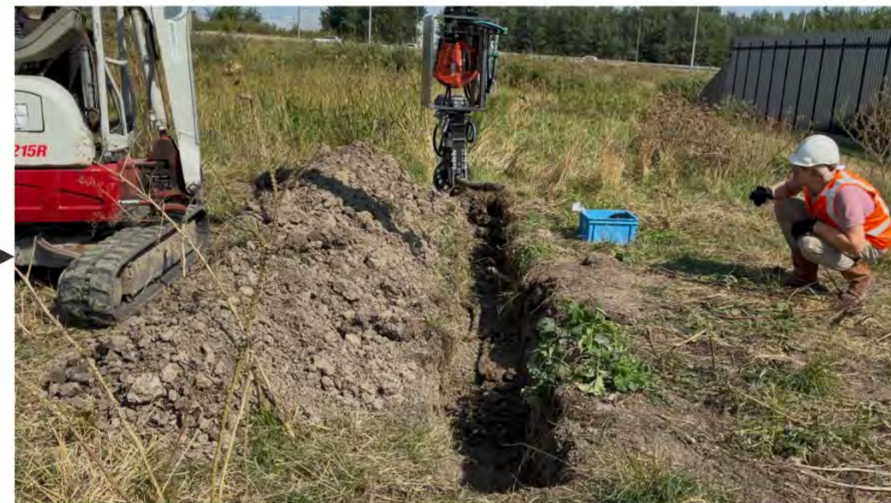
End-effector helemaal vast zetten met lier.
