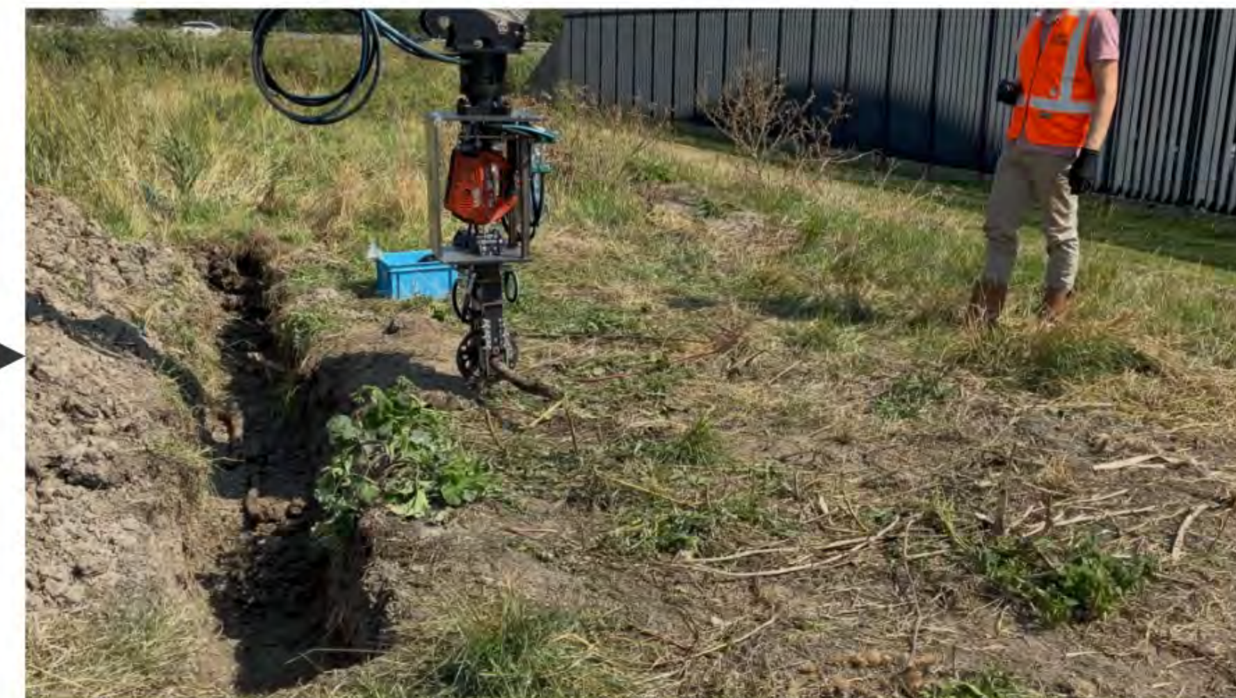
Kabel buiten de geul leggen.
