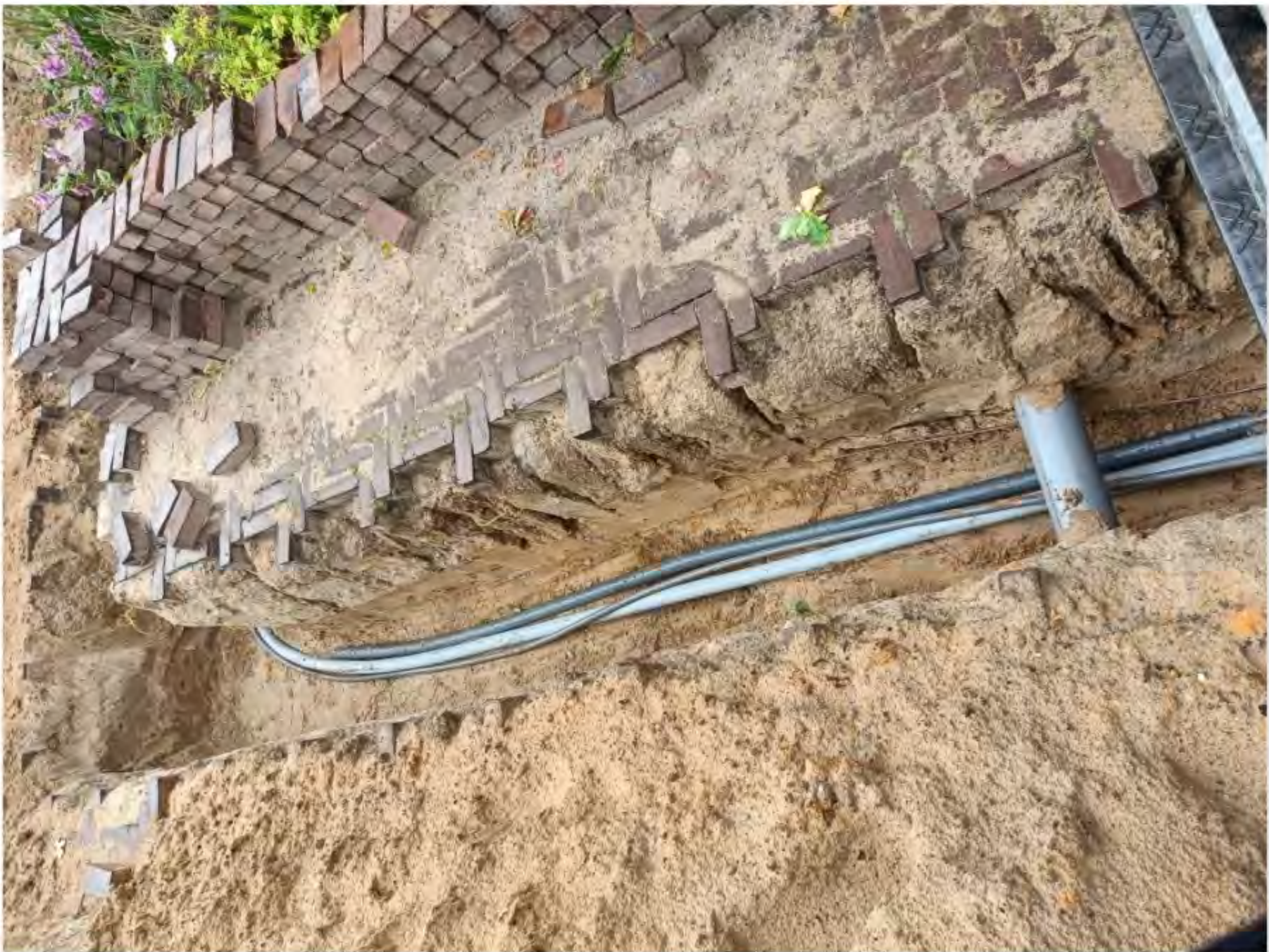
De gekozen lengte om af te knippen hangt af van de persoon. In de test was de conservatie inschatting tot lengtes van ca 3 meter. De ander ging tot zeker de dubbele lengte van 6 meter. Er is ook gesproken over de werkwijze om kleine moffen af te knippen en op de kant te leggen. De grote (oude) moffen moeten met de graafmachine.
