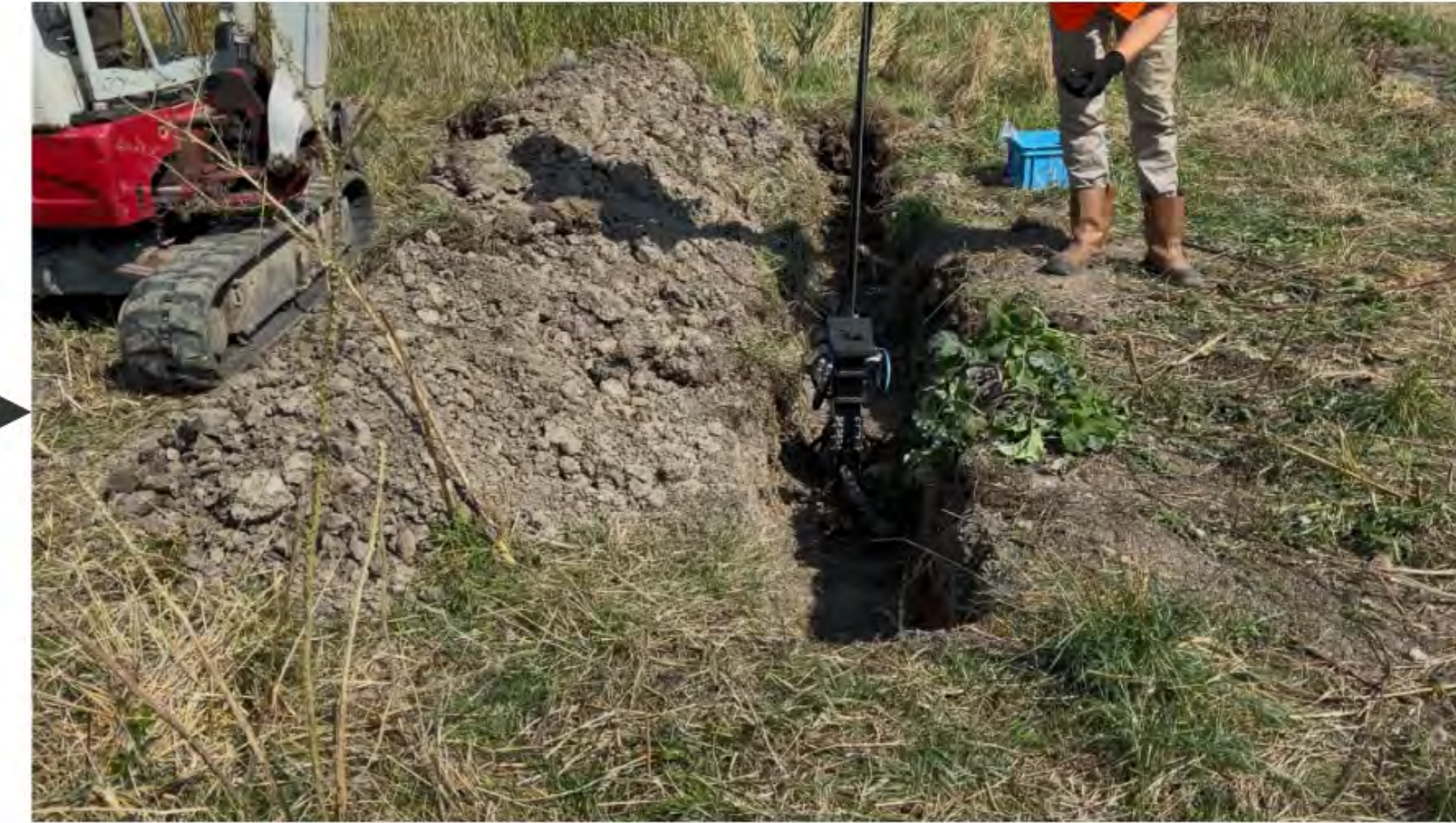
End-effector op module laten landen, en controle door grondwerker. Daarna knippen en grijpen.
