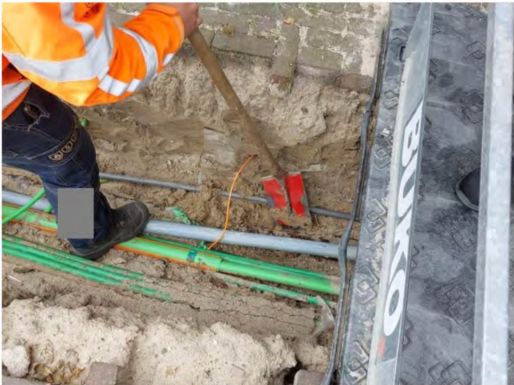
Kabels worden met bestaande gereedschappen in het zicht gebracht. Zoals op de foto met een bats. Het is daarbij niet altijd bekend of er nog andere infrastructuur onder ligt. Wat sterkt bepalend is voor het knippunt is waar een mof zit. Dit zijn plekken waar de kabel achter andere infrastructuur kan blijven haken.
