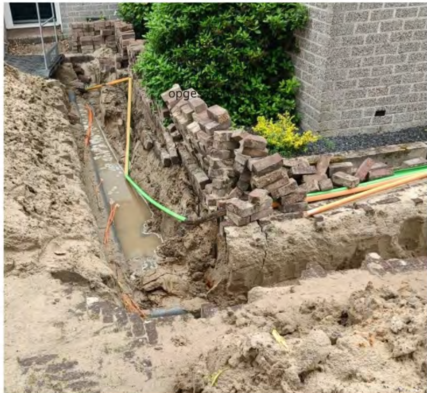
Zodra er water in de geul komt is er minder tot geen zicht op de kabels.
