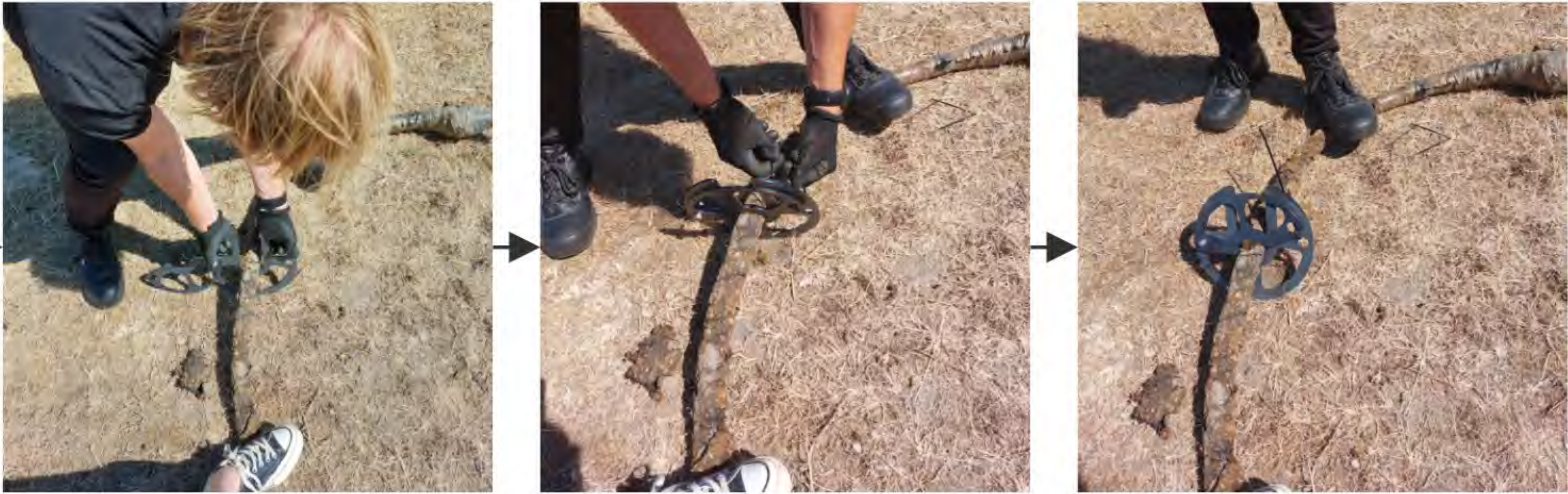
Het plaatsen van een 5mm dikke module om een kabel
