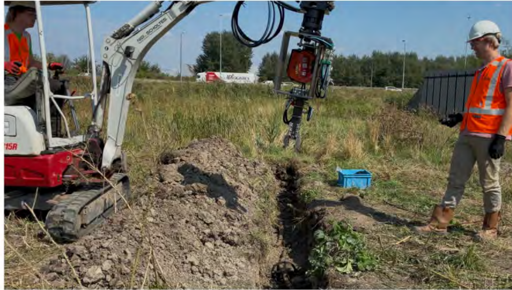
Positioneren van graafmachine met end-effector
