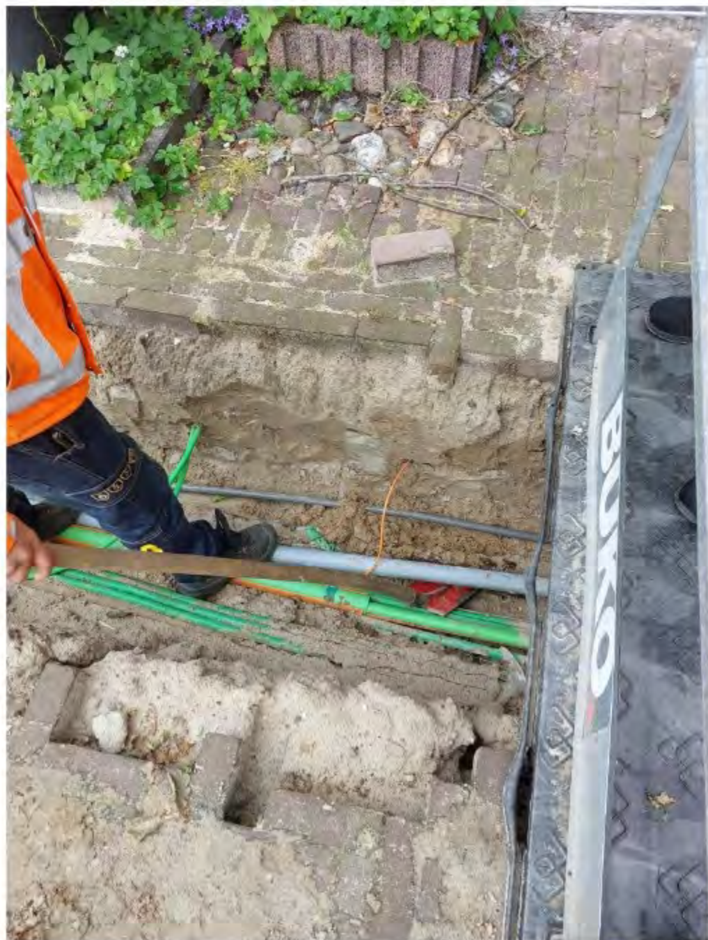
Bij het dokken of knippen moet er geen druk op de ondergrond komen voor het geval dat er andere infrastructuur onder ligt.
