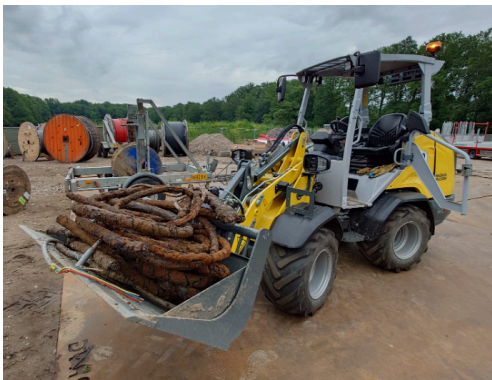
Kabels worden met shovel naar container gebracht
