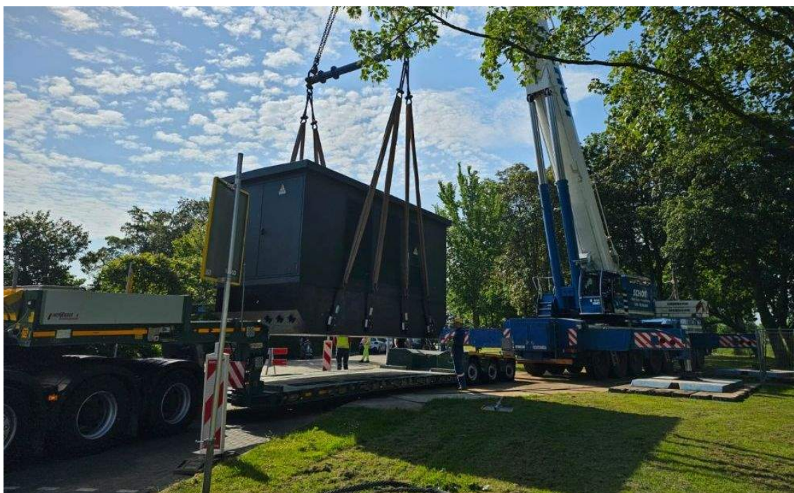
Het Liander programma Netuitbreiding Lelie (afgekort als NuLelie) is een samenvoeging van vele projecten. We leggen ruim 3.000 kilometer aan stroomkabels en plaatsen of vernieuwen ruim 400 elektriciteitshuisjes.
