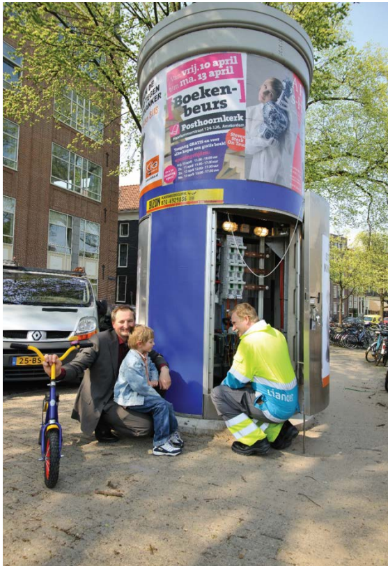
Een monteur van Liander voert werkzaamheden uit aan een middenspanningsruimte in Amsterdam
