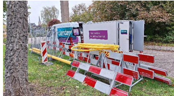
Figuur 6 – Werkzaamheden aan het Stiggoor
