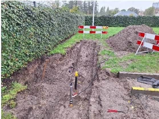
Figuur 7 – Spoelen koppelleiding invoedstation
